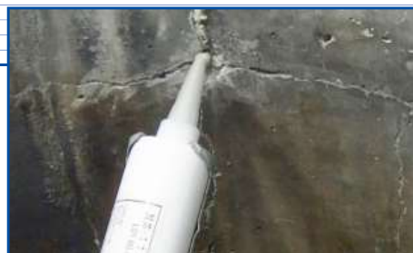
1 補修剤を亀裂に注入
