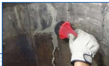
2 亀裂に塗り込む
